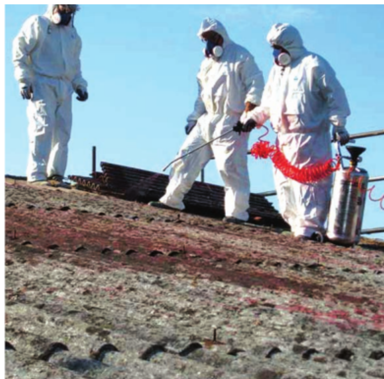
Rimozione di amianto da un tetto
